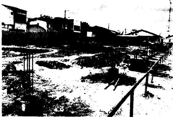
CONCRETAGEM DE SAPATAS
