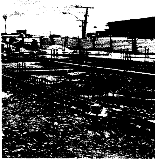
MONTAGEM DE FORMAS PARA VIGAS BALDRAME
