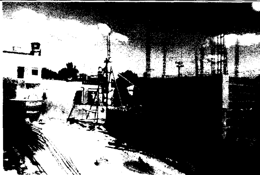
MONTAGEM DE FORMAS PARA PILARES
